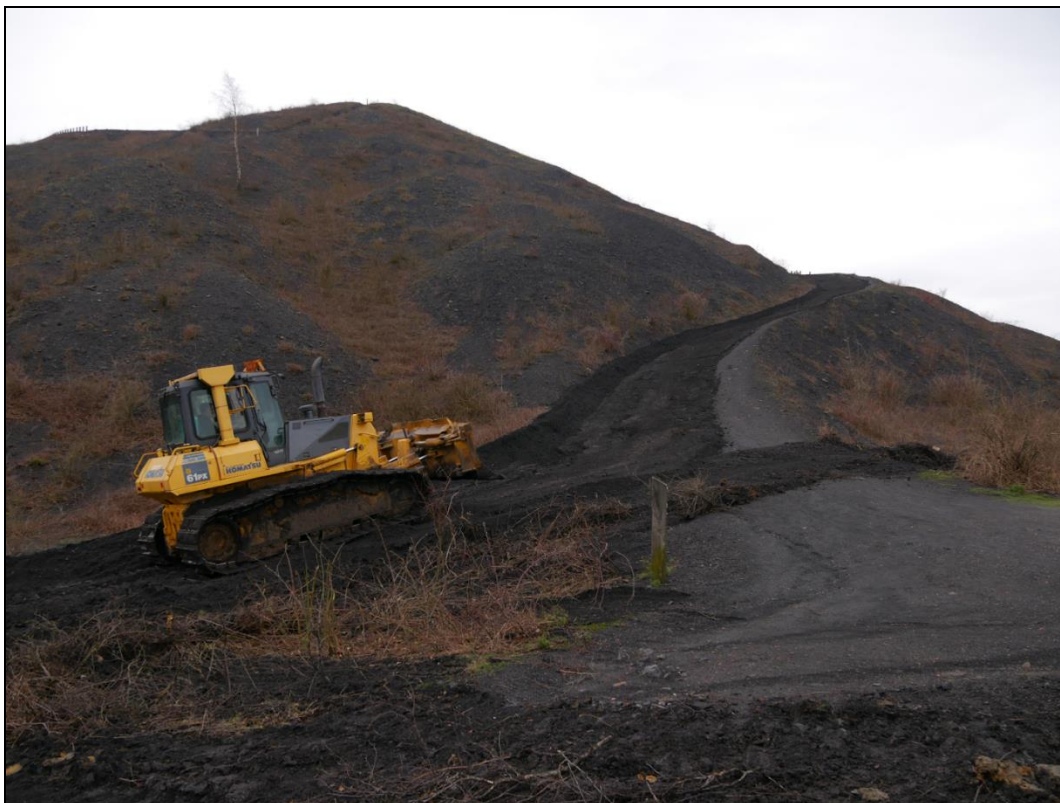
Encadrement des travaux de reprofilage des chemins d'accès à la pointe du terril en mars 2020
